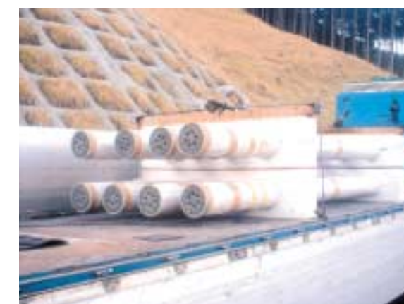
穴原高架橋(ストラット充填材)
